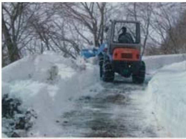
作業中（除雪ローダ 0.5m3級）
