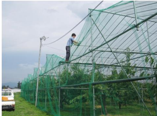
妻面のアーチパイプを1本はずして、 楽な体勢で作業できるようにしている (外側のアーチパイプは、クランプ付きの ジョイントで固定する)
