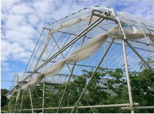
妻面に足場パイプを追加している
