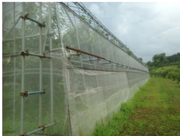
側面作業用の足場パイプを設置
