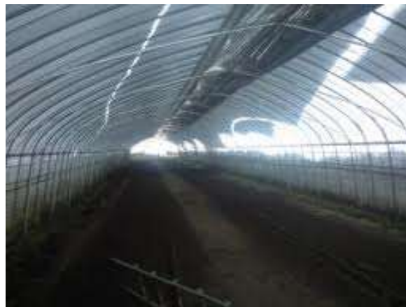
写真 11 無加温ハウスで、ハウス密閉により屋根面の雪が滑落している状況
