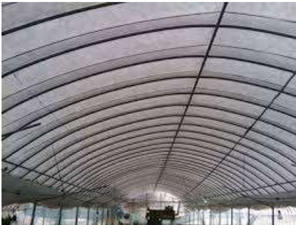
写真 9 屋根面に着雪し、融雪が必要となっているハウスの状況
