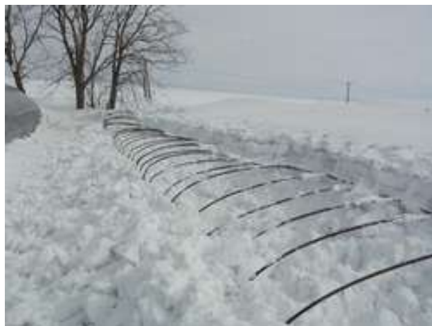
写真 24 雪に埋没したパイプハウスの掘上げ作業
