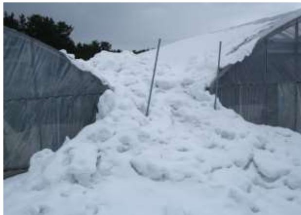
写真13 積雪がハウスの肩まで達し、 早急に除雪が必要な状況
