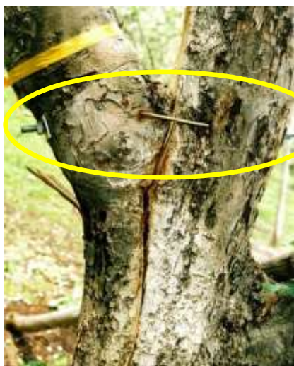
写真 16 ボルト、カスガイによる固定状況
