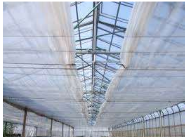
写真 10 内張りカーテンを開放し、屋根面の融雪を促す
