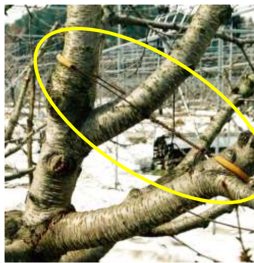
写真 17 ワイヤーによる補強状況
