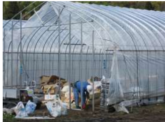
写真21 ハウス骨材と被覆資材の 補修作業の状況
