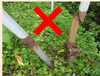
■劣化したパイプは交換
